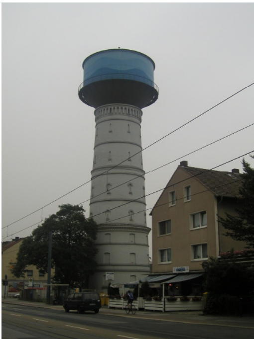
Bild 1: Die Wassertürme der RWW sind durch ihre exponierte Lage prädestiniert als Standorte für seNet ® -Basisstationen. Die Antennen sind nahezu unsichtbar an den teilweise denkmalgeschützten Gebäuden angebracht.
